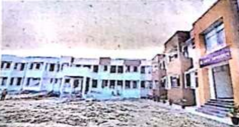
करसड़ा में निर्माणाधीन सिपेट हास्टल • जकाब
