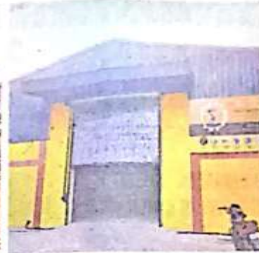
आईटीआई करौली में हाई टेक लेब का हुआ निर्माण • जकाब
