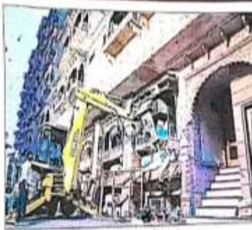
बेटीके टिका इलाक़े में एक भवन को ध्वस्त करने के लिए एक एक्सकैवटर का उपयोग।
