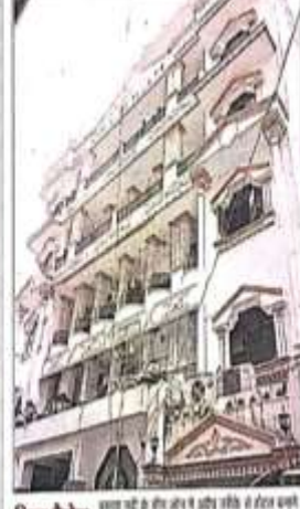
वाराणसी के होमर क्षेत्र में होमर होटल की नई इमारत का निर्माण।
